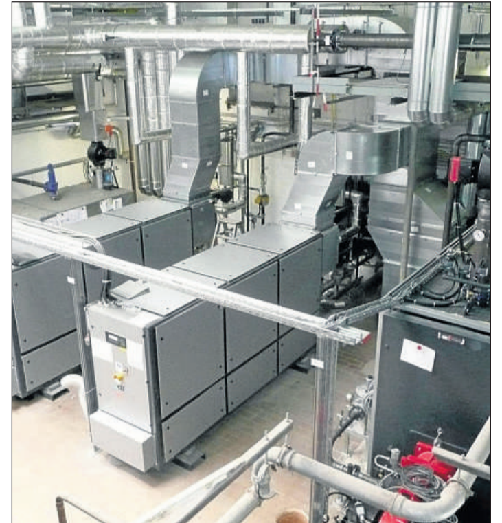
Auch im Kreiskrankenhaus in Eschwege hat die Firma Seeger Engineering eine Anlage mit Kraft-Wärme-Kopplung realisiert. Foto: privat
