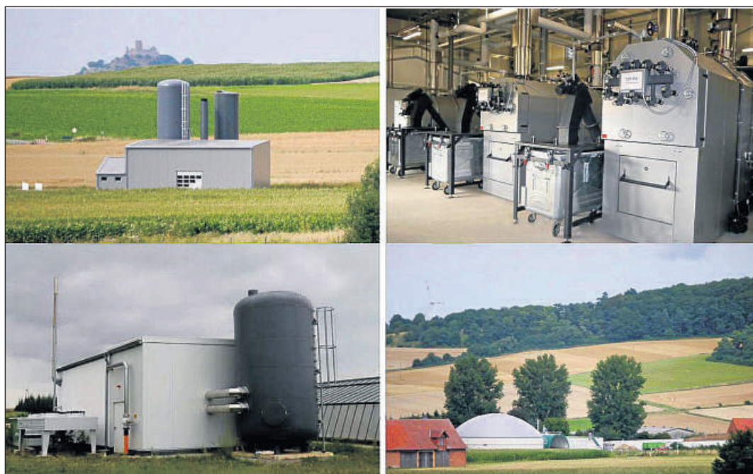
Die drei Säulen des Bioenergie-Projekts in Wettesingen: Oben sind das moderne Pellet-Heizwerk und im Hintergrund die Burg Calenberg in Nordrhein-Westfalen zu sehen. Unten links das Blockheizkraftwerk im Ort, rechts die Biogasanlage mit Kraftwerk. Sie ist die Keimzelle der Bioenergie. Fotos: Viessmann/HN
